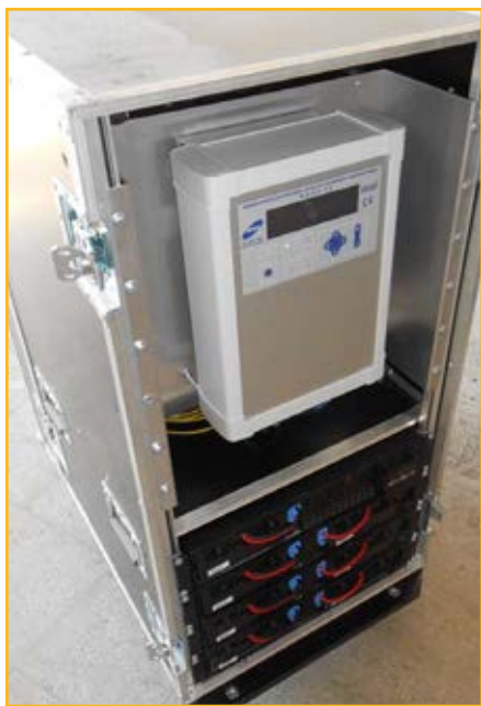
Fot. 2 Przenośna stacja ochrony katodowej.
