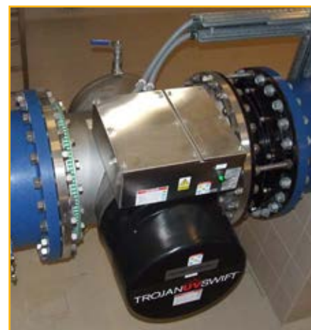
Instalacja dezynfekcji wody - ZUW Raba. Lampa UV 700 mm.
